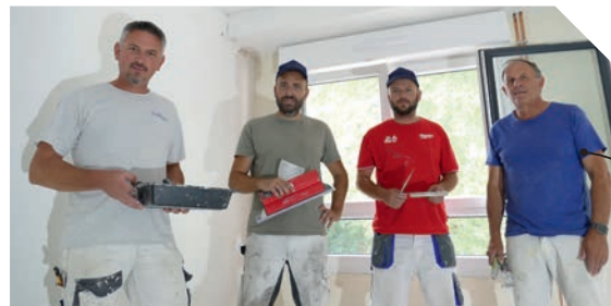
Les peintres en bâtiment de la Ville ont consacré plusieurs semaines à la rénovation des salles du Centre de la Coursaudière.
