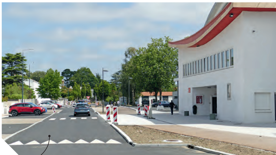
Les travaux du boulevard Jean-Yole touchent à leur fin.
